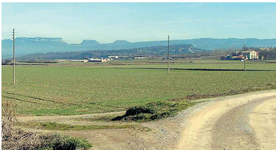
Fotografia 7. Línia B.T., amb conductor nu (també anomenat cable convencional)
