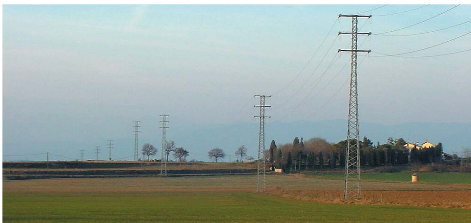
Fotografia 5. Línies M.T., 25 kV doble circuit sobre suports metàl·lics de gelosia.
