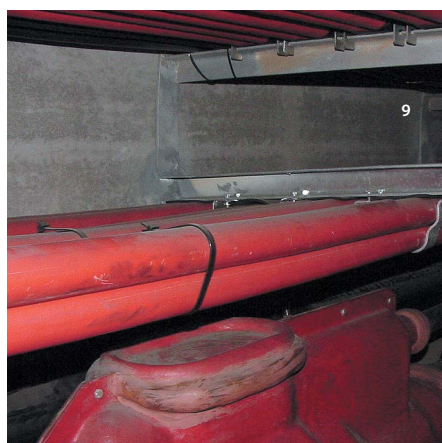
Fotografia 9. Composició. Detall de galeria de serveis. Les dues fotografies superiors mostren circuit de 25 kV. A les dues inferiors s'aprecia el detall d'una caixa d'empalmaments d'una línia de 220 kV. Tots els conductors són de cable sec XLPE.
