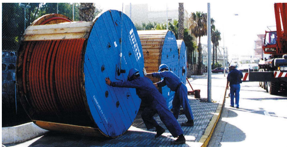
Fotografia 1. Bobina de cable
